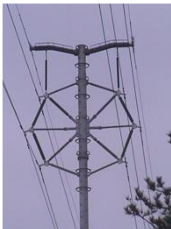
Rys. 2 Słup kompaktowy 420 kV typu New Diamond [2]
