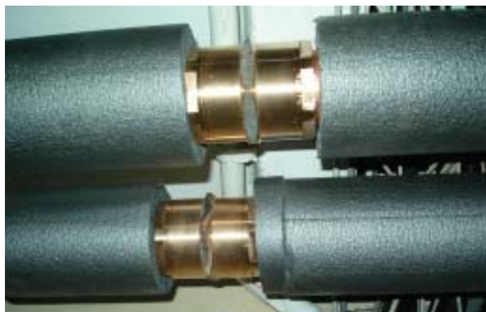
Rys.2.11 Kompensator typu O-yster Ø54
