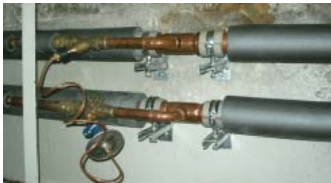
Rys. 3.16.1 Punkt stały z odejściem na trójniku
