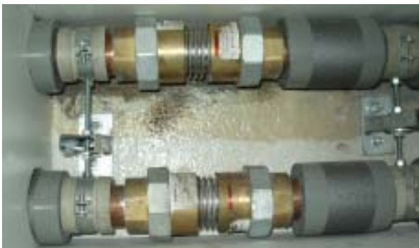
Rys. 3.14.1. Kompensator typu mieszkowego \varnothing 54 ze stali kwasoodpornej z półrubunkami
