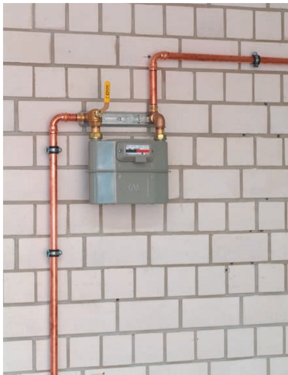
Rys . 7.25. Standardowe uchwyty z uszczelka z EPDM
