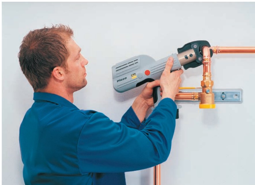
Rys.6.3. Narzędzie systemowe z pełną kontrolą zacisku
